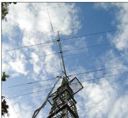
Der wuchtige Funkturm des Pacific Palau Resorts samt Richtantennen (Force 12 C3 und ein Beam für 40) sowie einem Dipol für 80 m
