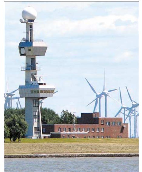
Entlang der Küste überwachen Verkehrszentralen mit Radar, AIS und Sprechfunk den Schiffsverkehr – im Bild der mit Antennen belegte Turm der Verkehrszentrale Emden Knock. Foto: W. Arendt, WSA Emden 2005
